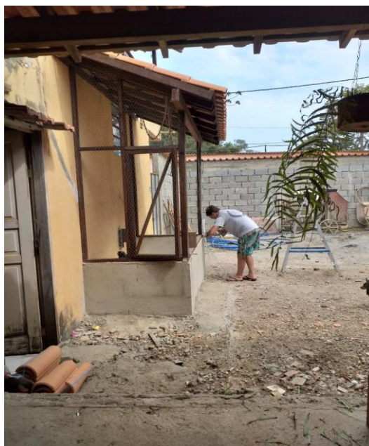
Figura 6 - Viveiro de alvenaria em fase de construção na residência da tutora
