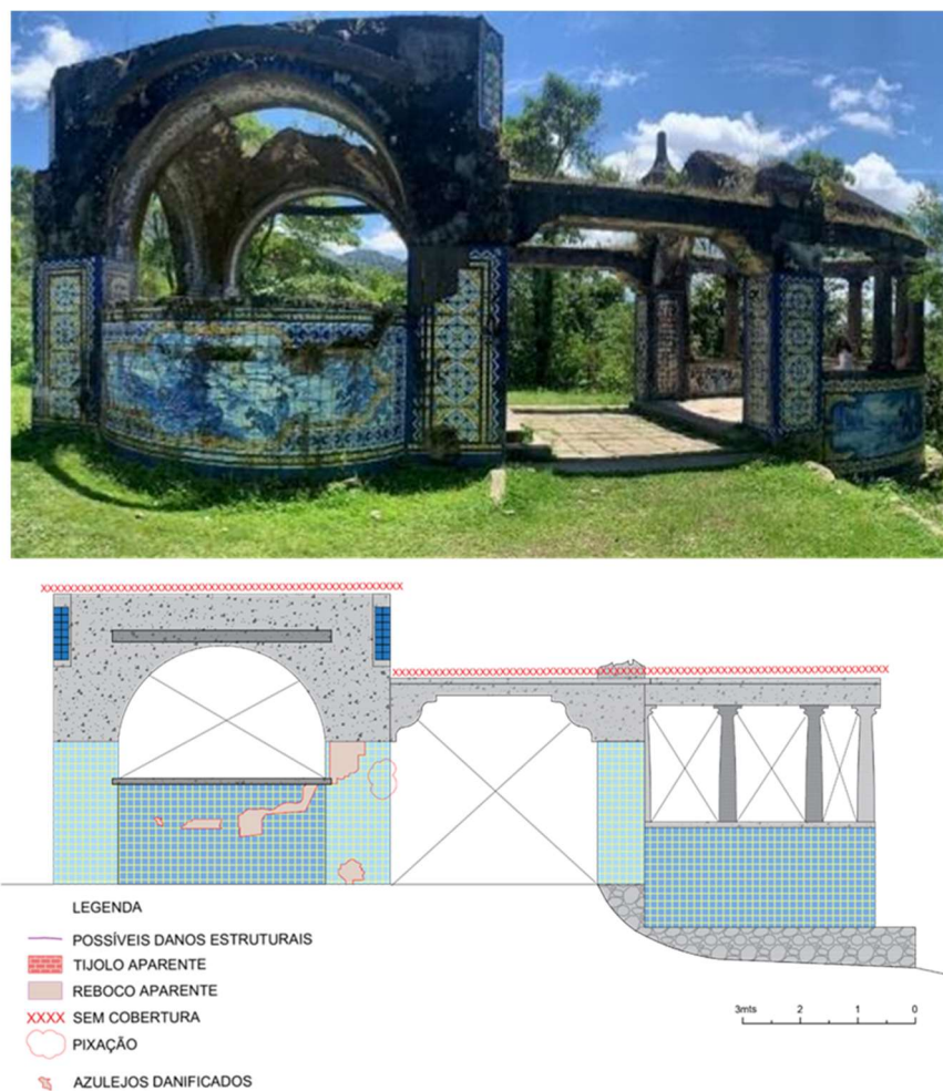
Figura 2 – Foto e Mapeamento de Danos da Fachada Norte. Fonte: autores, 2023.
