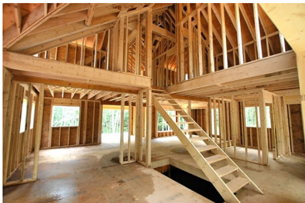
Figura 4: Aplicação de Wood Frame
