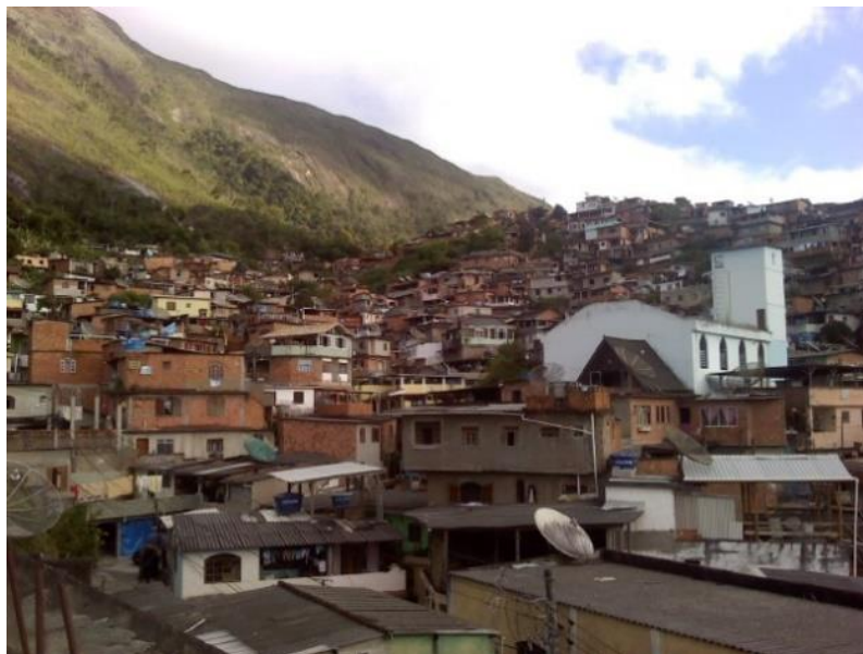
Figura 4: Favelização nas encostas da cidade
