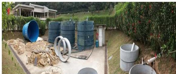
Colocação de 230 manilhas para escoamento de águas pluviais e transbordo da água da mina.
