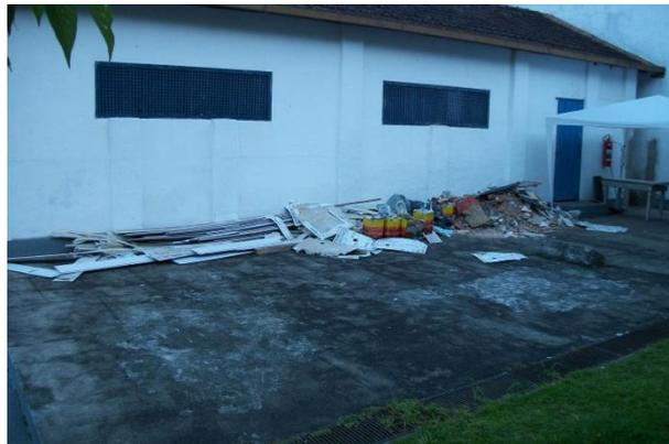
Figura 3: Resíduos sólidos oriundo de obras. Material resultante de reparos nas instalações do campus. Multiplicidade de resíduos como plásticos, madeiras, tijolos e latas de tinta. Tais resíduos deveriam ser armazenados em caçambas com tampa e os recipientes de tinta devem ser lavados e destinados separadamente.
