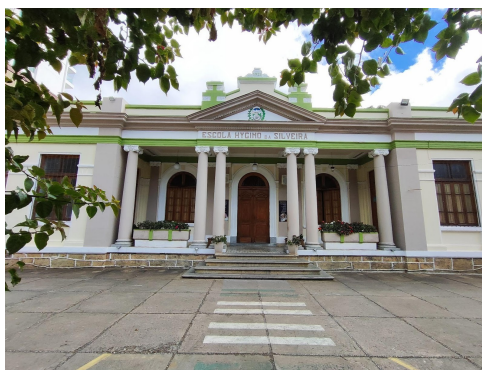
Figura 1- Foto da fachada frontal do Higino da Silveira.
