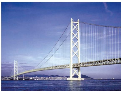
Ponte da Normandia (vão central 856 m).
