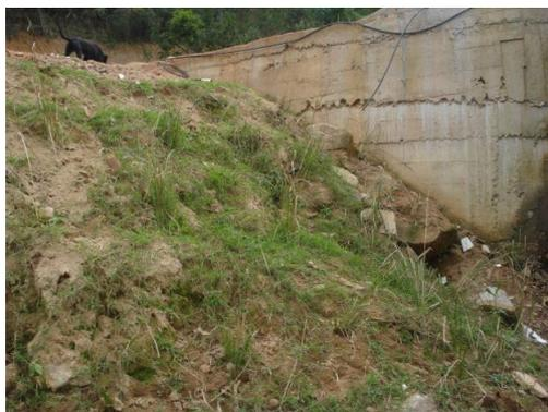
**Figura 3** – Talude de aterro onde foram plantadas as mudas do vetiver. (Foto: Alves, 2014)
